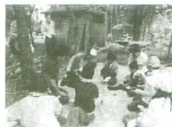
写真-1 遊歩道整備風景
