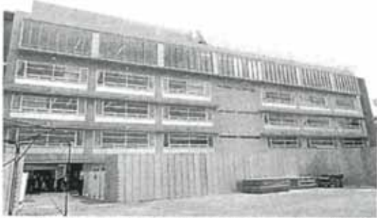
施工Ⅱ東急建設
