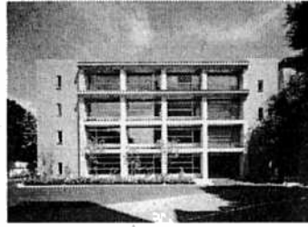
完成した新2号館
