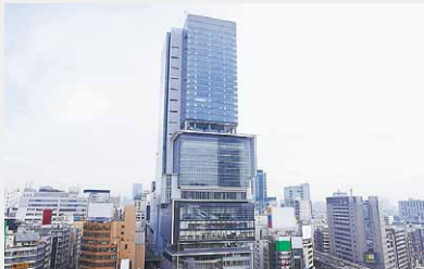
東急グループは本拠地である渋谷の再開発を進めています。2012年4月には渋谷駅周辺のリーディングプロジェクトである高層複合施設「渋谷ヒカリエ」が開業しました
